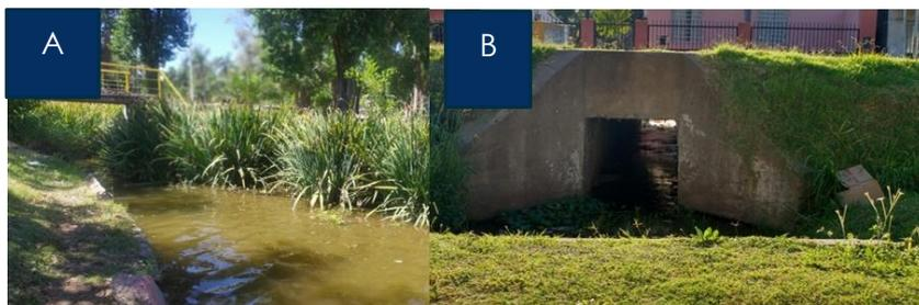
**FIGURA 25.** A): DETALLES DEL SITIO DE INGRESO DEL AGUA AL LAGO. B) DETALLES DE LA ALCANTARILLA UBICADA SOBRE AV. P. ZANNI QUE RECOGE LOS APORTES FLUVIALES QUE POSTERIORMENTE DESEMBOCAN EN EL LAGO.
