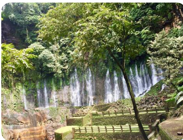
Figura 3. Hidroeléctrica La Calera 1.45MW
