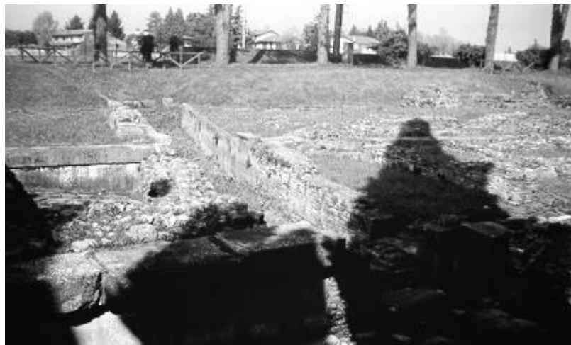
Figura 1.1 – Antiguo drenaje romano del puerto de Aquileia, Italia (foto J. Macor)
