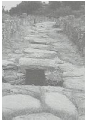
Figura 1.2 – Desagüe romano de Hannaba, Argelia (Chocat y otros, 1997)
