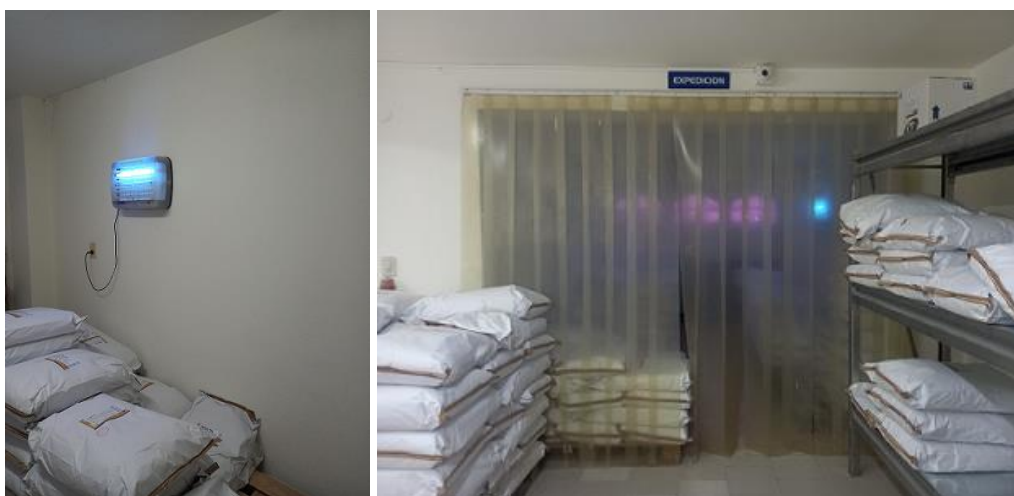
FIGURA 15: Medidas de exclusión (Trampa UV y cortinas PVC)
