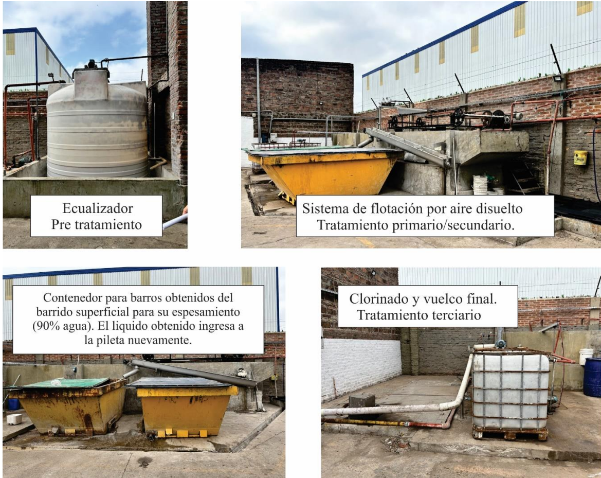
Imagen 5.3: Tratamiento de efluentes líquidos de la planta en estudio
