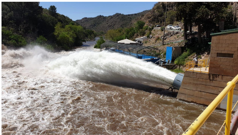
Figura 7.3: Estado actual con obras importantes que permiten aumentar la capacidad de evacuación.
