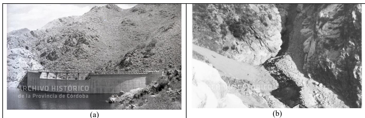
Figura 5.6: (a) Dique Los Alazanes, (b) Dique La Viña. Construidos por la DGH de Córdoba
