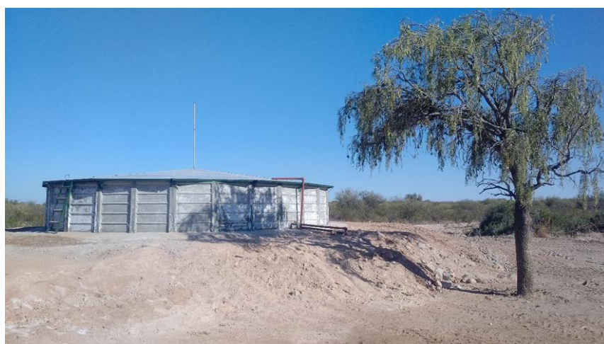
Figura 2: Nuevo Tanque acopio 100 m 3 Estación de re-bombeo Portón Rojo dotado de tapa metálica.
