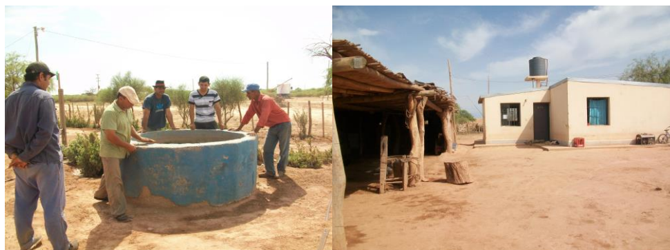
Figura N° 8.1.4-2: Relevamiento en sistemas de captación de lluvia domiciliarios en San Pedro, departamento Capital, provincia de La Rioja.
