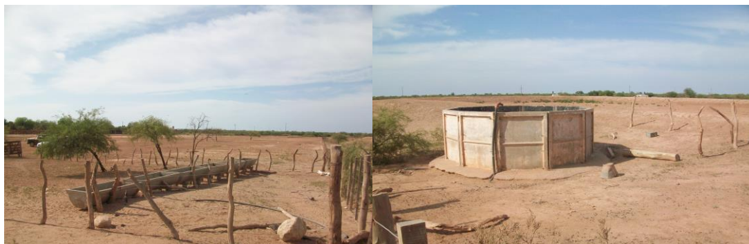
Figura N° 8.1.4-5: Represa N°2 San Pedro, departamento Capital, provincia de La Rioja, detalles de bebederos y tanque de placas de 5 m 3 destinado al abrevado animal.
