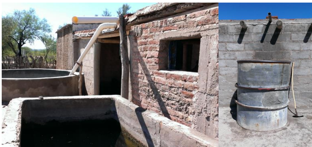
Figura N° 8.1.3-5: Depósitos para almacenar agua de lluvia en viviendas de la Comunidad de La Paz, departamento Rosario Vera Peñaloza, provincia de La Rioja.
