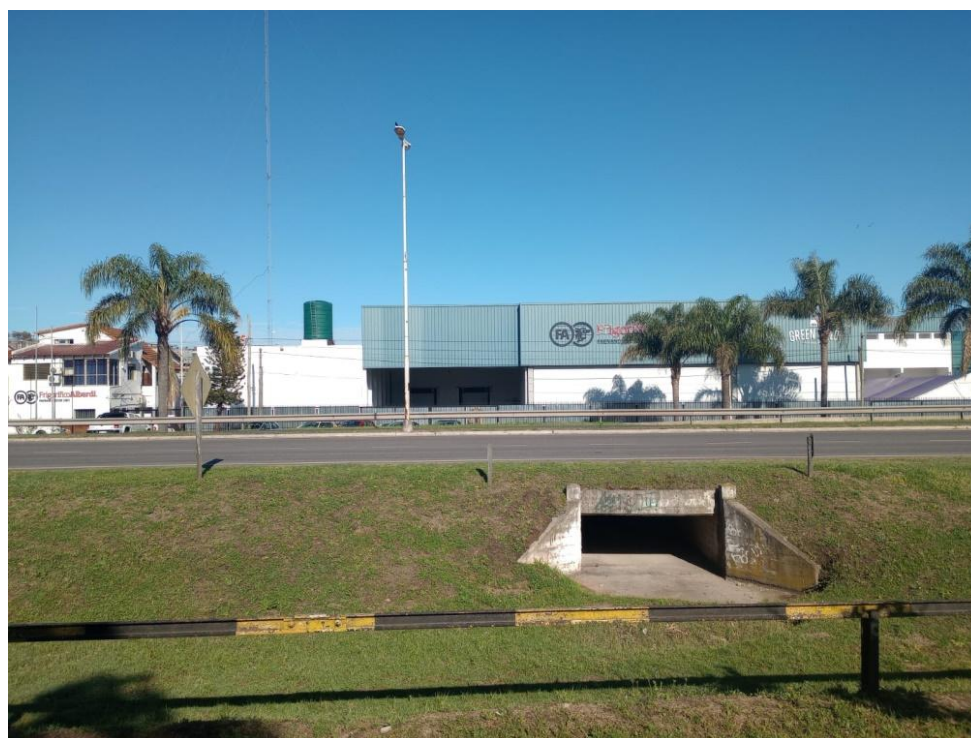
Figura 12: Vista frontal del Frigorífico Alberdi. Se puede observar infraestructura asociada al curso del arroyo Paracao. Fecha 06/11/24.
