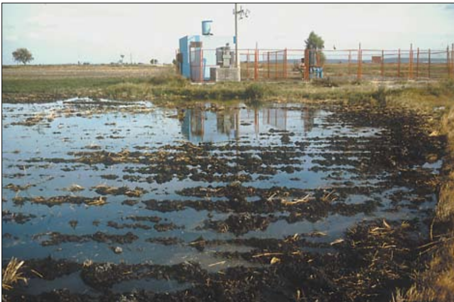
b) zona operacional del pozo dimensionada y protegida en forma inadecuada, amenazada por riego agrícola con aguas residuales urbanas
