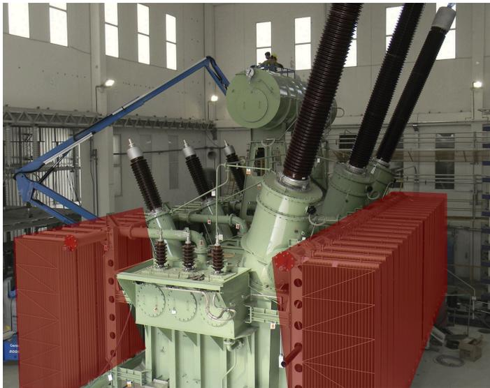
**Figura 1.21:** Intercambiadores de calor (radiadores) de un transformador de potencia sombreados en color rojo.
