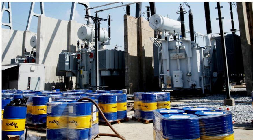
**Figura 1.7:** Proceso de llenado de los transformador de potencia.
