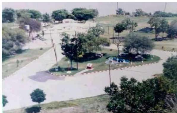
Foto 7.7. Obras sector Anfiteatro 1985. Fuente: Villa Urquiza de Antaño.
